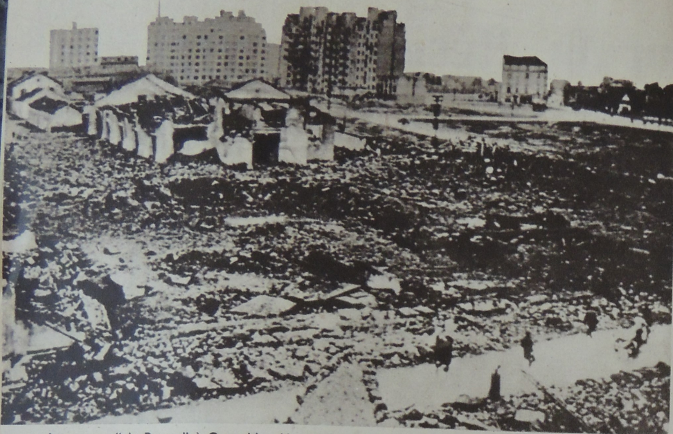
La caserne "de Bonne" à Grenoble, détruite par l'action des patriotes français. Déjà, au cours de la nuit du 13 novembre, des Français avaient fait sauter le Parc d'Artillerie de Grenoble, dont la Wehrmacht se servait comme centre de munitions et de réparation. Les Allemands ayant arrêté des otages, un ultimatum leur fut aussitôt envoyé, demandant leur libération immédiate. Ils le rejetèrent. Ce fut à la suite de ce refus que les patriotes procédèrent, le 2 décembre, à la destruction de la caserne. L'explosion coûta à l'ennemi 200 morts et 500 blessés.
